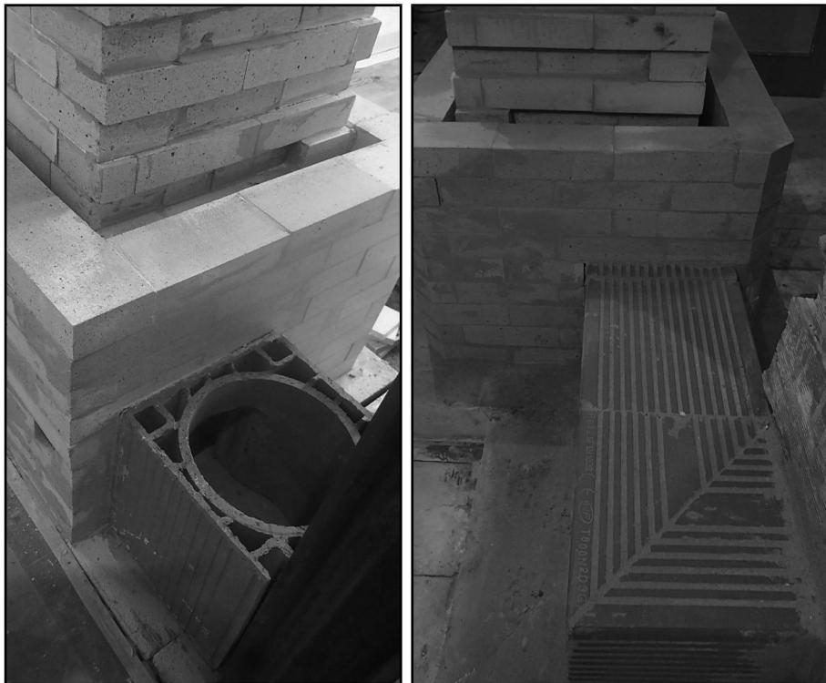
Connexion du poêle au conduit sans et avec banc
