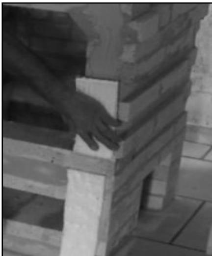
La laine céramique est utilisée pour réaliser des joints de dilatation étanches au passage des gaz et fumées. Elle est souple et mesure 13mm d'épaisseur.
