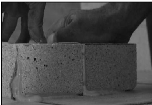
Il est possible de maçonner le poêle entièrement au coulis argileux. Il est alors préférable d'éviter des chauffes intenses et il faut impérativement utiliser la « boîte à feu » pour préserver le foyer.
