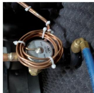
2. Brancher le vacuomètre sur une prise de pression libre. Laisser la vanne fermée.
