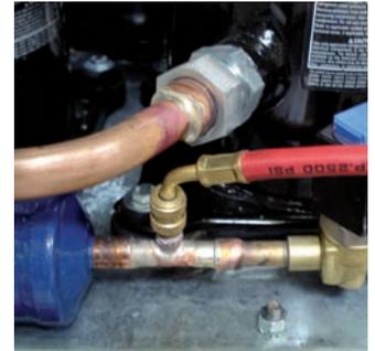
3. A l'aide des thermomètres contrôler la surchauffe et le sous refroidissement tout en rajoutant du fluide afin d'affiner la charge.
