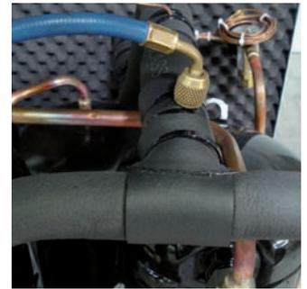
2. Brancher le manomètre HP au refoulement.
