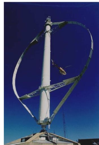
Figure 5 – Différents types de rotor Darrieus
