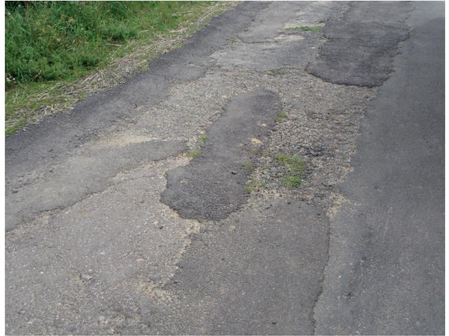
Fig. 2.27 Chaussée rigide dégradée avec ornière longitudinale. Les réparations successives créent des différences de surface qui sont autant d'obstacles verticaux.
