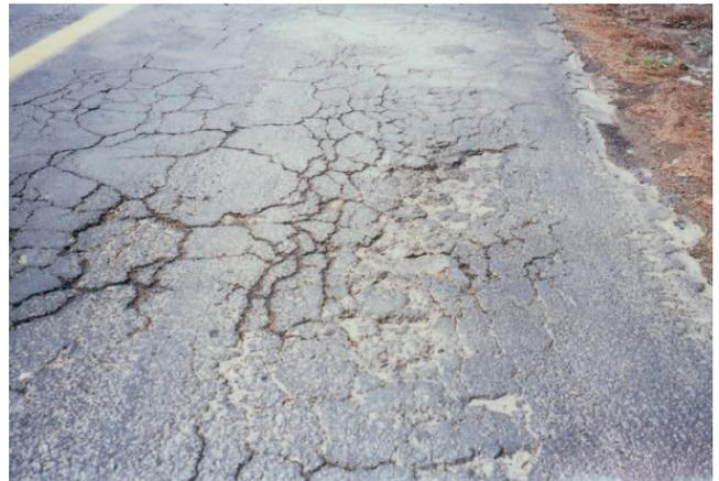
Fig. 2.36 Chaussée rigide dégradée avec amorce de nid de poule et présentant des obstacles aléatoires.
