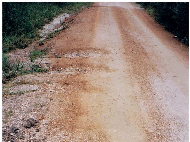
Fig.2.24 Plusieurs nids de poule de différentes profondeurs sur une chaussée non revêtue.
