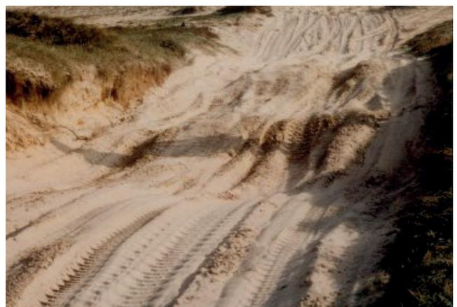
Fig. 2.35 Exemple d'ondulations sur chaussée souple (sable).
