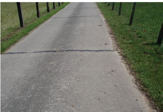
Fig.2.34 Raccordement de plaques de béton.
