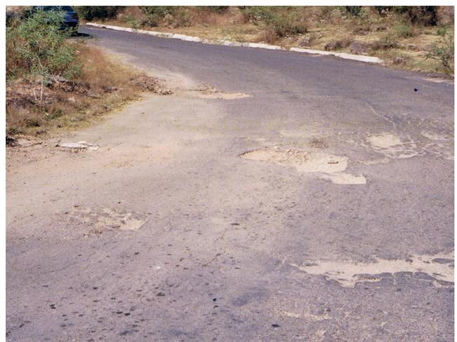
Fig. 2.25 Exemple de formation de nids de poule sur une chaussée rigide, par disparition localisée de la couche superficielle de roulement.
