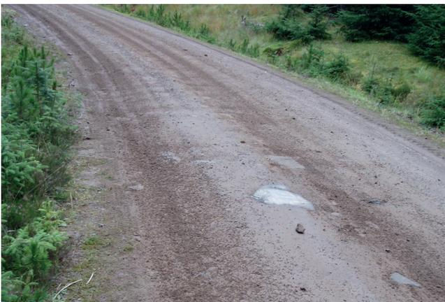
Fig. 2.29 Zone de tôle ondulée dans une courbe sur une chaussée non revêtue. Cela forme des barres transversales régulièrement espacées.
