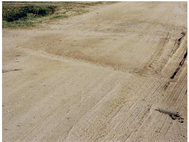
Fig. 2.28 Exemple de saignées transversales d'écoulement d'eau sur sol non revêtu.
