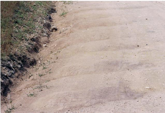
Fig. 2.31 Détail d'une zone de tôle ondulée à l'intérieur d'une courbe.
